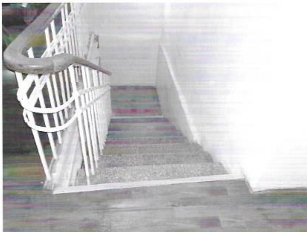
Лестница №1 первая и последняя ступени выделены контрастным цветом, отсутствует второй поручень
