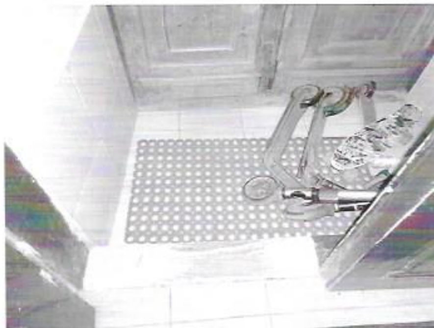
Тамбур входной группы имеет пороги, ширина тамбура менее 1м
